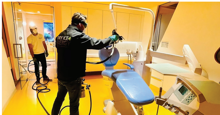
Alle relevanten Oberflächen in der Berliner Zahnarztpraxis KU64 wurden mit der innovativen Dry-Ice-Energy-Beschichtung überzogen und reduzieren damit erheblich das Risiko einer Keimübertragung vor Ort. (Foto: Petros Prontis/KU64.de)
