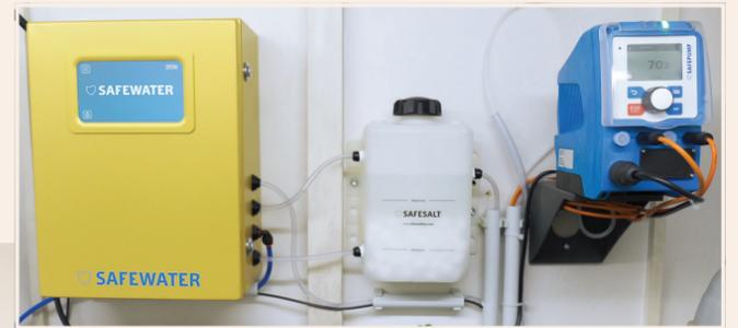
Zentral implementiert versorgt SAFEWATER sämtliche Entnahmestellen der Trinkwasserinstallation der Praxis.
