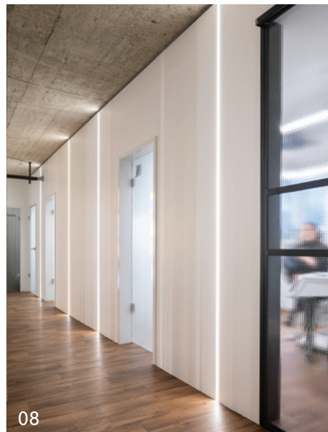
07 und 08 Spiel mit Licht: LED-Stripes sind flächenbündig in den Trockenbau eingelassen, sodass zwischen den Behandlungszimmern keine Deckenlampen nötig sind.
