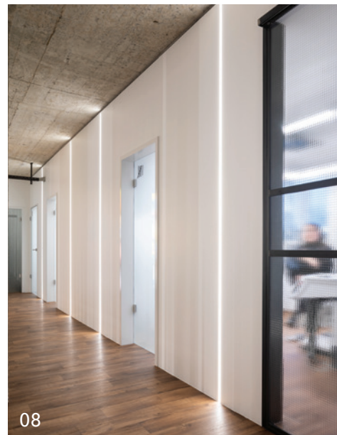
07 und 08 Spiel mit Licht: LED-Stripes sind flächenbündig in den Trockenbau eingelassen, sodass zwischen den Behandlungszimmern keine Deckenlampen nötig sind.
