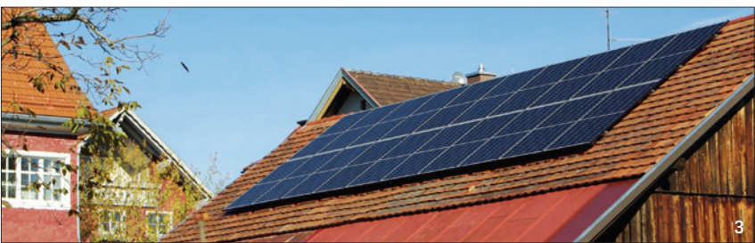
Abb. 1: Das 1925 erbaute Gebäude vor dem Umbau. Abb. 2: Zum Energieeffizienzhaus saniertes Wohn- und Laborgebäude. Abb. 3: Die Photovoltaikanlage zur Energiegewinnung im Dentallabor.
