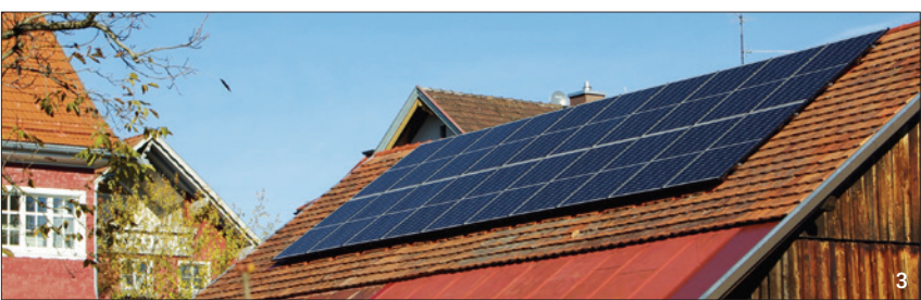
Abb. 1: Das 1925 erbaute Gebäude vor dem Umbau. Abb. 2: Zum Energieeffizienzhaus saniertes Wohn- und Laborgebäude. Abb. 3: Die Photovoltaikanlage zur Energiegewinnung im Dentallabor.
