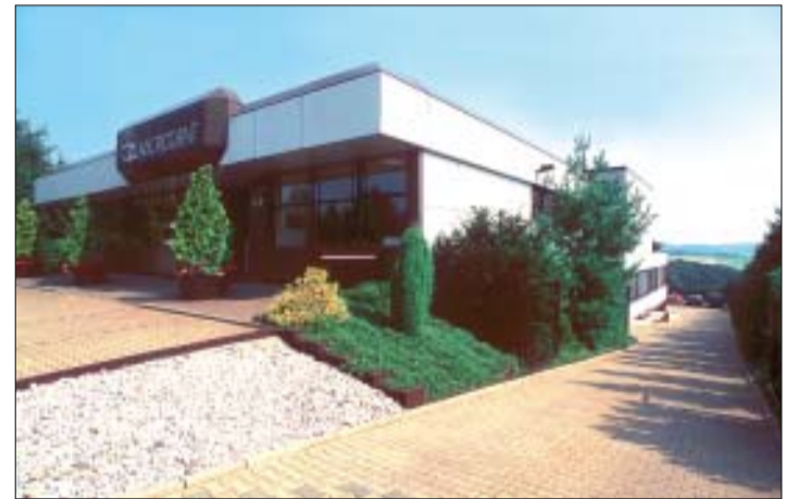
Seit 1980 befindet sich der Firmensitz der ZL-Microdent in Breckerfeld im nordwestlichen Sauerland.
