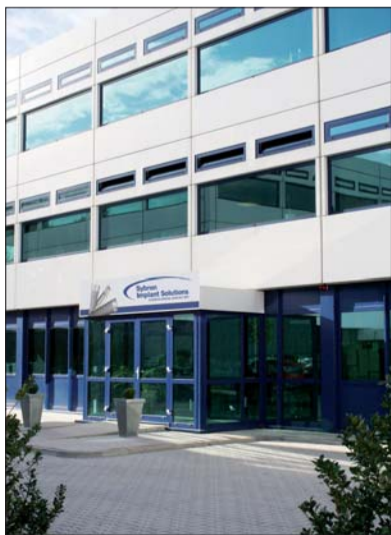
Das neue, im September 2007 bezogene Firmengebäude.
