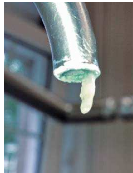
Biofilme in Trinkwasserinstallation und in dentaler Behandlungseinheit
