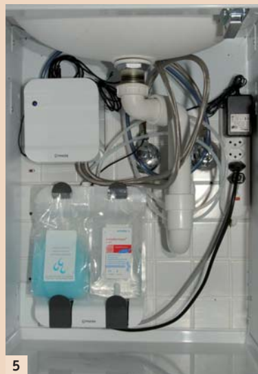
Abb. 5: Montageelemente im Unterbau-Schränkelement: separates Wasser- und Dispensionsmedien-Modul. – Abb. 6: Modulbox für Seife und Desinfektionslösung mit Einweg-Beutelsystem. – Abb. 7: Modulbox für Seife und Desinfektionslösung mit Mehrweg-Flaschensystem.
