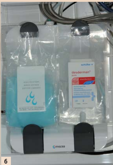
Abb. 5: Montageelemente im Unterbau-Schränkelement: separates Wasser- und Dispensionsmedien-Modul. – Abb. 6: Modulbox für Seife und Desinfektionslösung mit Einweg-Beutelsystem. – Abb. 7: Modulbox für Seife und Desinfektionslösung mit Mehrweg-Flaschensystem.
