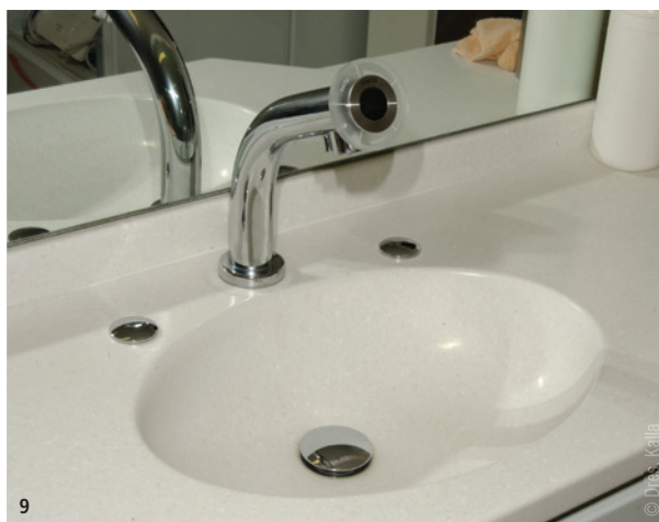
Abb. 7: Selbstreinigendes und -desinfizierendes Toilettensystem: CWS. – Abb. 8: Zahnbürsten, Raumduft-Dispenser und wieder aufbereitbare kleine Frotteehandtücher in der Patiententoilette. – Abb. 9: MISCEA Multifunktions-Wasserspender am Waschbecken. – Abb. 10: Selbstklärende Funktionen am Glasring mit integriertem Display.
