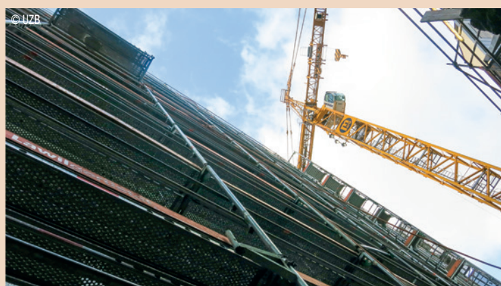
Der Neubau der UZB kommt termingerecht voran.
