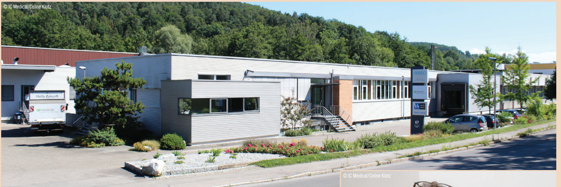
Firmengebäude in Rudersberg-Steinberg.
