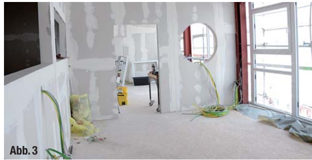
▲ Abb. 2 und 3: Nach Fertigstellung der Dachkonstruktion wurden die Innenwände gestellt. Bis Mitte September 2014 wurden rund 480 Quadratmeter neue Gipskartonwände angebracht.
