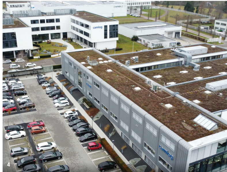
Abb. 4: Das CAMLOG System hat von Anfang an überzeugt und schnell viele Anhänger gefunden. Entsprechend rasant wächst das Unternehmen, 2018 erfolgte bereits der zweite Erweiterungsbau.
