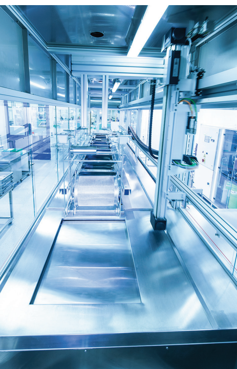
Die vollautomatische Waschstraße im firmeneigenen Reinraum.
