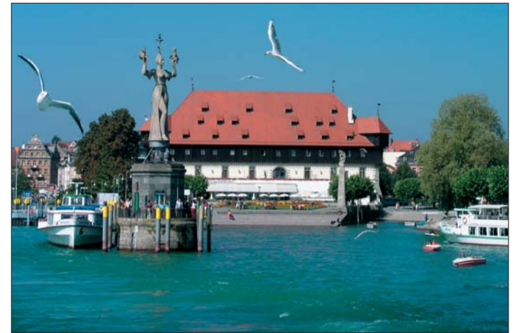
Das jahrhundertalte Konzil ist – früher wie heute – ein beeindruckendes Bauwerk direkt am Bodensee.
