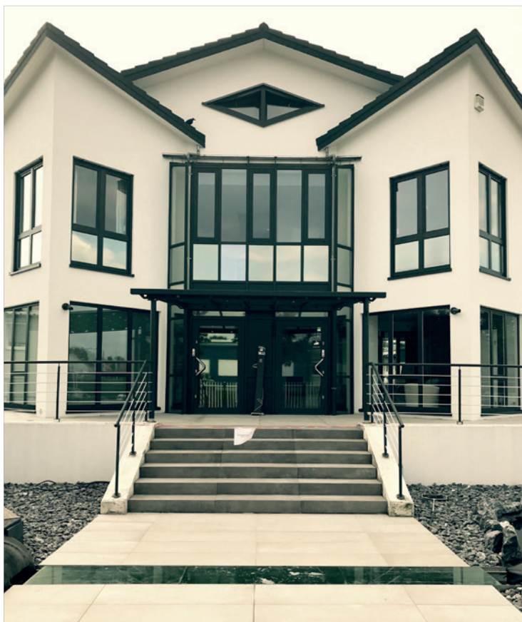
Der frisch sanierte Hauptsitz in Walsrode.
